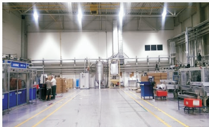
Po rekonštrukcii inštalované svietidlá ALBEO 147W
